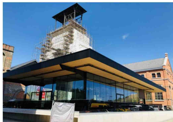
Naast het ophaalgebouw is een glazen nieuwbouw neergezet. FOTO CN
