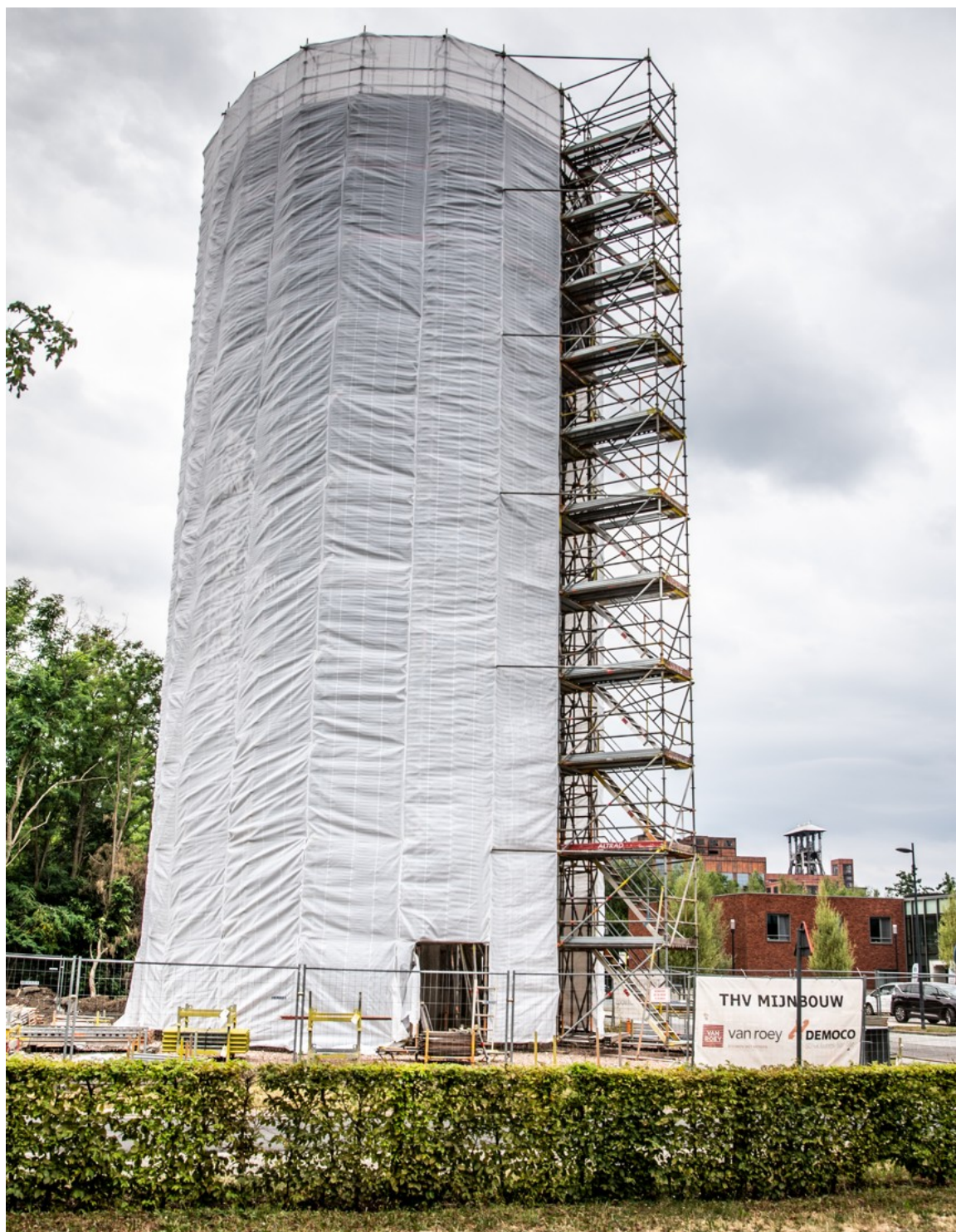
De negentigjarige watertoren is helemaal ingepakt voor de restauratie. FOTO RAYMOND LEMMENS
